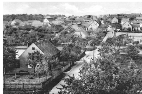
Richard Reinicke Straße, vom Wasserturm aufgenommen
