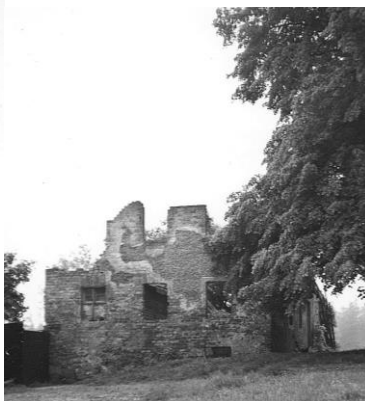
Ruine des Wohngebäudes am Windmühlenberg - 1970
